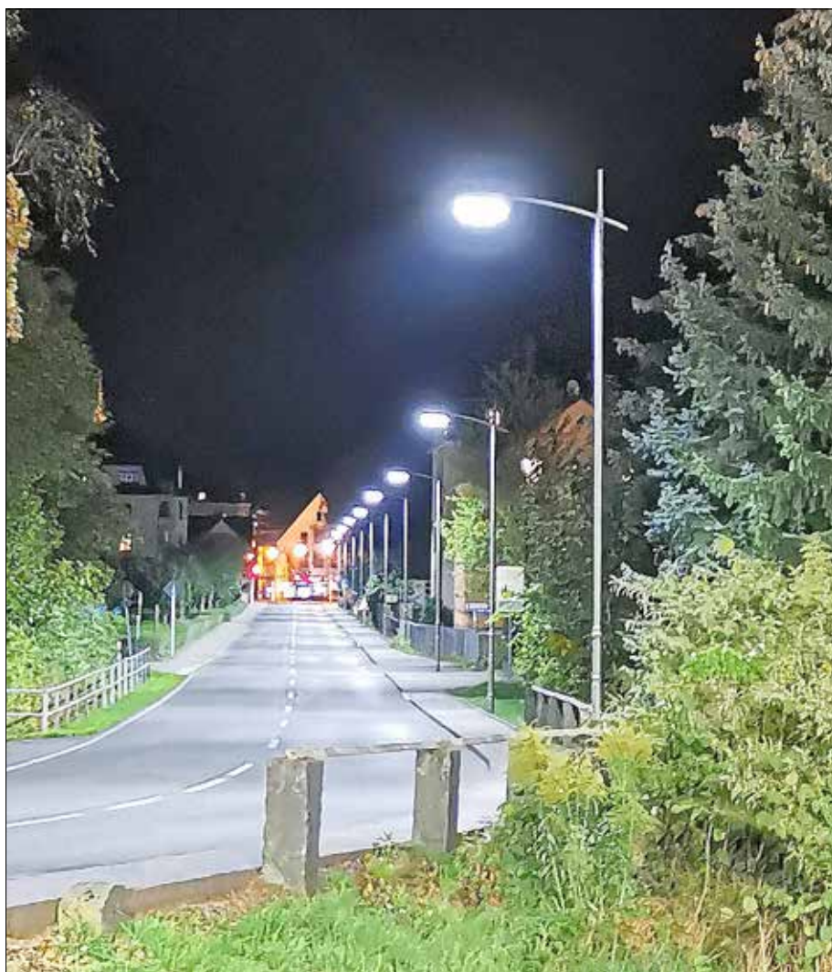
Umgestaltung der Straßenbeleuchtung auf der Dresdner Straße mit Umrüstung auf LED-Technik
